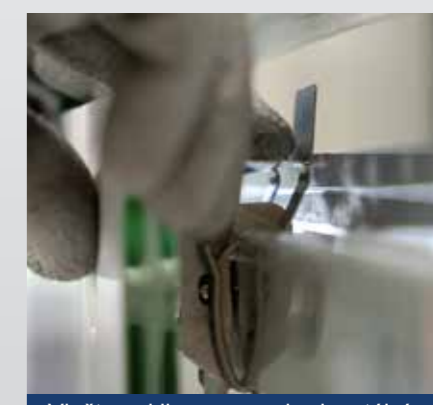
Vložte klip pro horizontální zajištění panelu.
